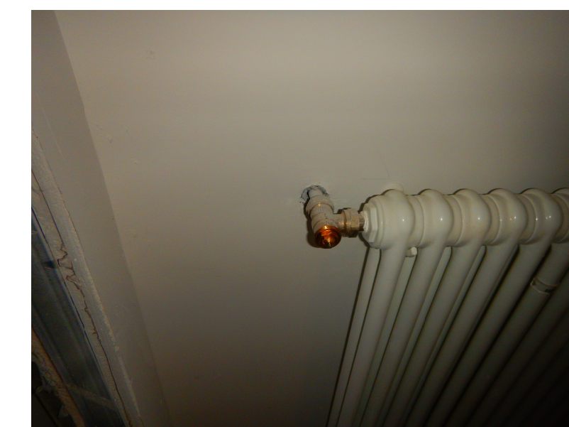
foto 4 - montare valvole termostatiche
