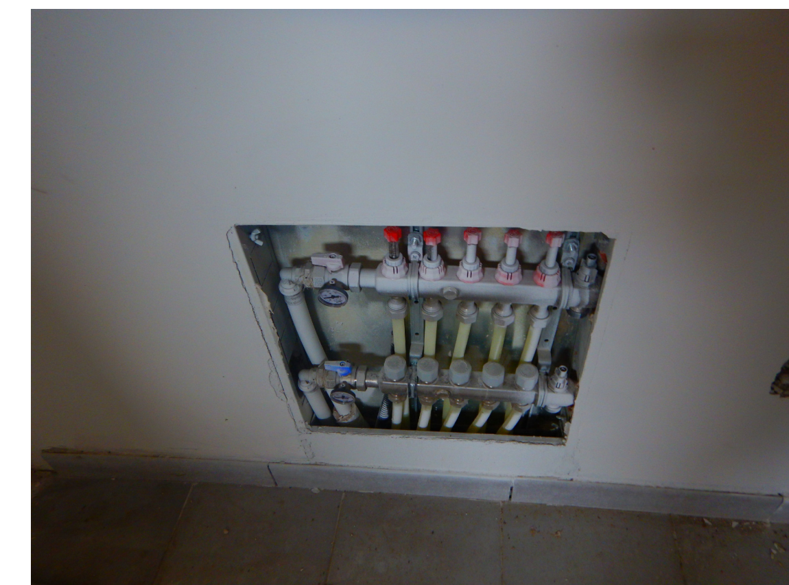
foto 6 - montare testine elettrotermiche collettori pannelli rad.
